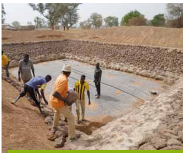
Bassin de collecte de l'eau de ruissèlement
